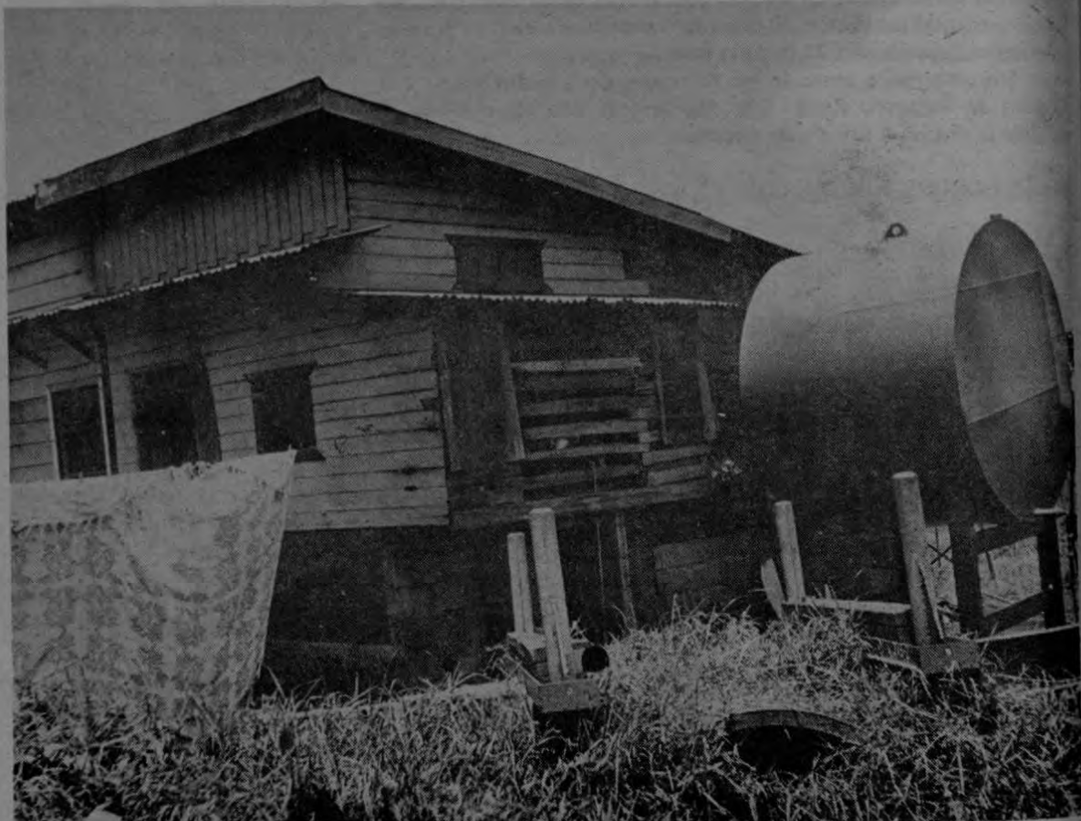
En ese tanque almacenan los chancheros el agua de la cañería de San Roque. Los vecinos se quedan sin agua.
